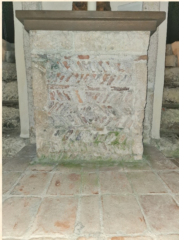
Abbildung 20: Altar in der Krypta der Kirche St. Pantaleon in Opus Spicatum Mauerwerktechnik. (Foto: Lehenbauer Harald)
