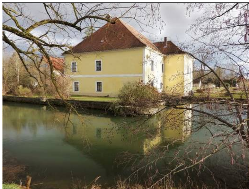
Abb. 26: Foto des Wasserschlosses St. Pantaleon von Westen aus gesehen. Etwa mittig (etwas verdeckt durch den ins Bild ragenden Ast) ein Fundamentrest eines Wehrturmes, dazu links die Futtermauer, der Wehrgraben und rechts das vorspringende, südliche Seitenrisalit. Quelle: R. S. Zappe, 03.01.2024.
