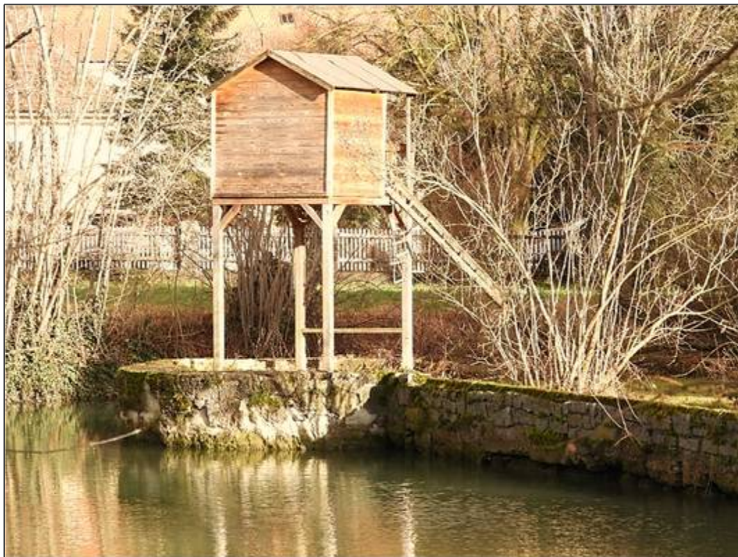
Abb. 27: Foto eines Fundamentrestes als Teil der Futtermauer des Wassergrabens des Wasserschlosses St. Pantaleon an der Nord-West-Seite. Quelle: R. S. Zappe, 03.01.2024.
