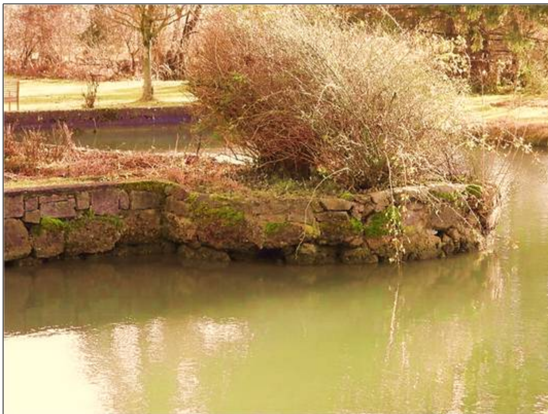
Abb. 28: Foto eines Fundamentrestes als Teil der Futtermauer des Wassergrabens des Wasserschlosses St. Pantaleon an der Süd-West-Seite. Quelle: R. S. Zappe, 03.01.2024.
